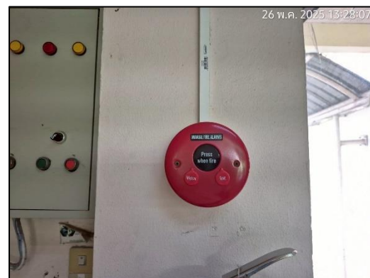
ภาพที่ 22 ระบบแจ้งเหตุแบบใช้มือ (Manual Station)
